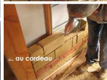
une fois posé, le mur sera jointé ou enduit
